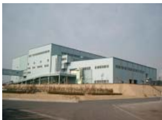
倉敷市・資源循環型廃棄物処理施設
