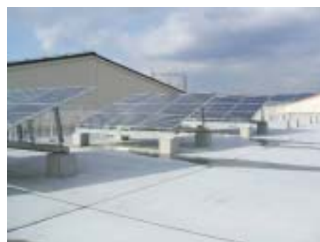
太陽光発電システムの設置 市立倉敷南小学校（5kW）
